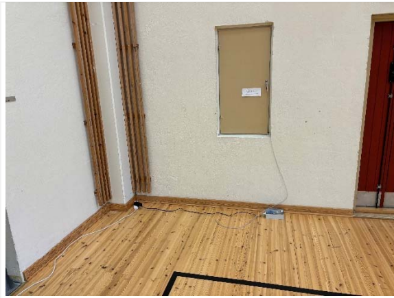
Kuva 2. Paine-ero mittaus liikuntasalin ikkunnasta ulkoilmaan.
