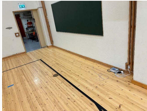
Kuva 6. Paine-ero mittauspiste liikuntasalista lattian eristetilaan.
