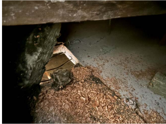
Kuva 80. Näyttämön 202 alla on noin puolen neliön kokoinen reikä alla oleviin tiloihin.
