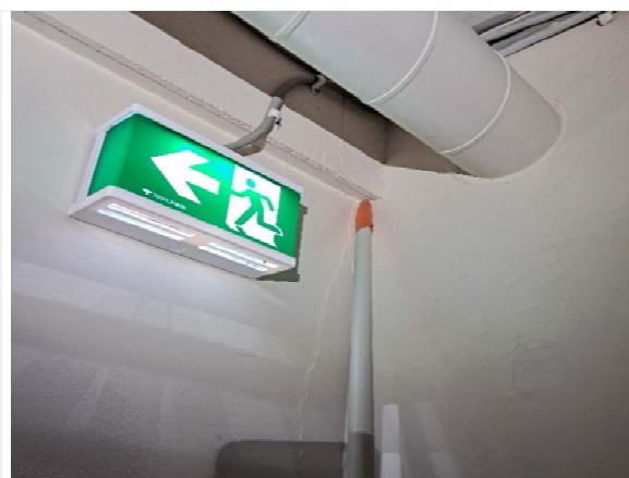
Kuva 74. Vuotopaikka sähköjohdon läpiviennistä.
