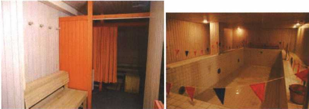
Kuva 5-4 Kellarikerroksen pukuhuonetilojen seinät ovat paneelia ja lattiassa on kokolattiamatto.
