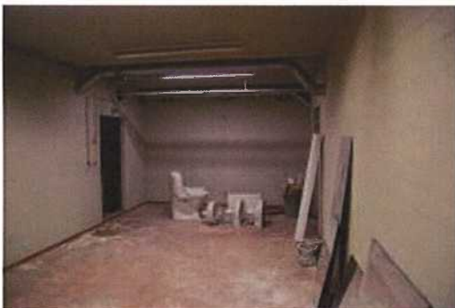
Kuva 5-2 Tyhjiään oleva väestösuoja.
