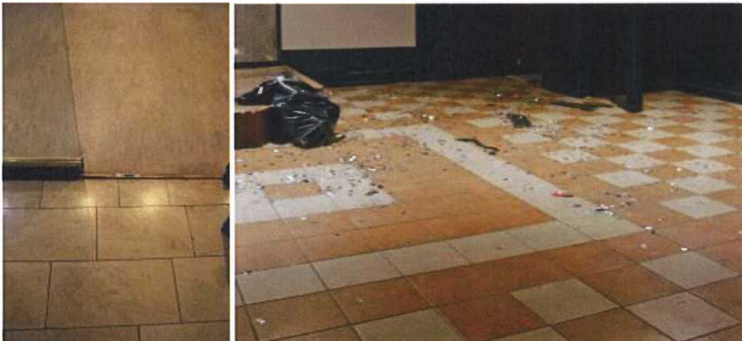
Kuva 4-166 Pankkisalilin ja myymälätilan lattiamateriaalit sekä kellarikerroksen keraamiset laatat.
