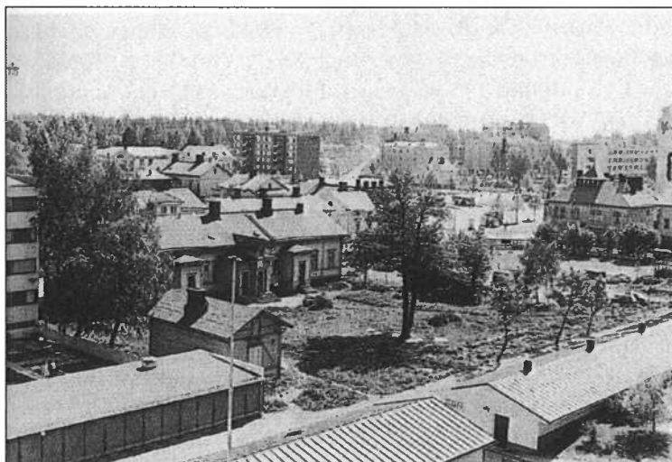
Kuva 4-1 Pankkitalon ja viereisen asuinrakennuksen tontti ennen rakentamista (kuvalähde Tiura 2004)
