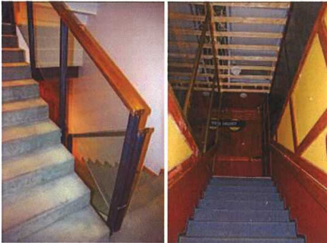
Kuva 5-17 C- ja E-porraskäytävät.
